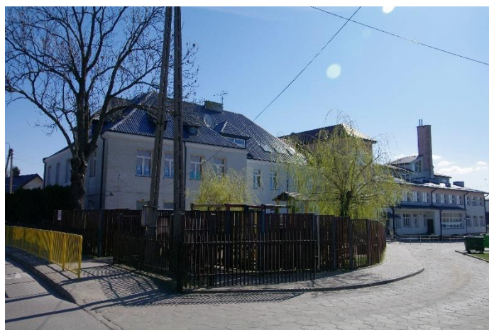
Budynek Szkoły Podstawowej im. Adama Mickiewicza w Sokołach
