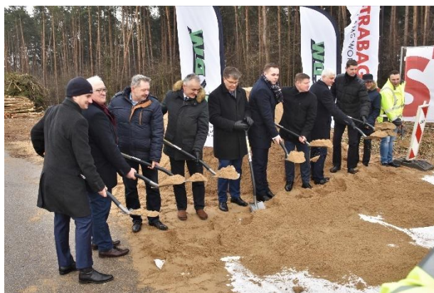
Rozpoczęcie prac nad obwodnicą Sokół
